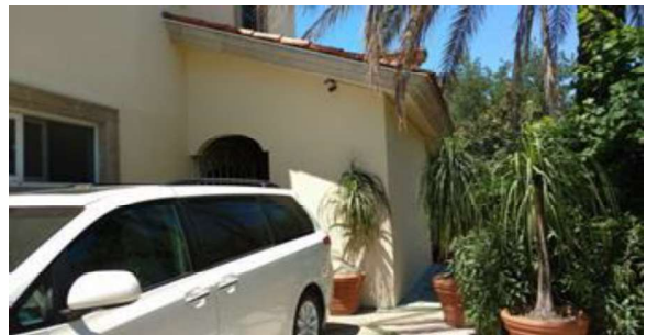
Vista exterior de bodega
