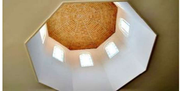
Cúpula que cubre la escalera
